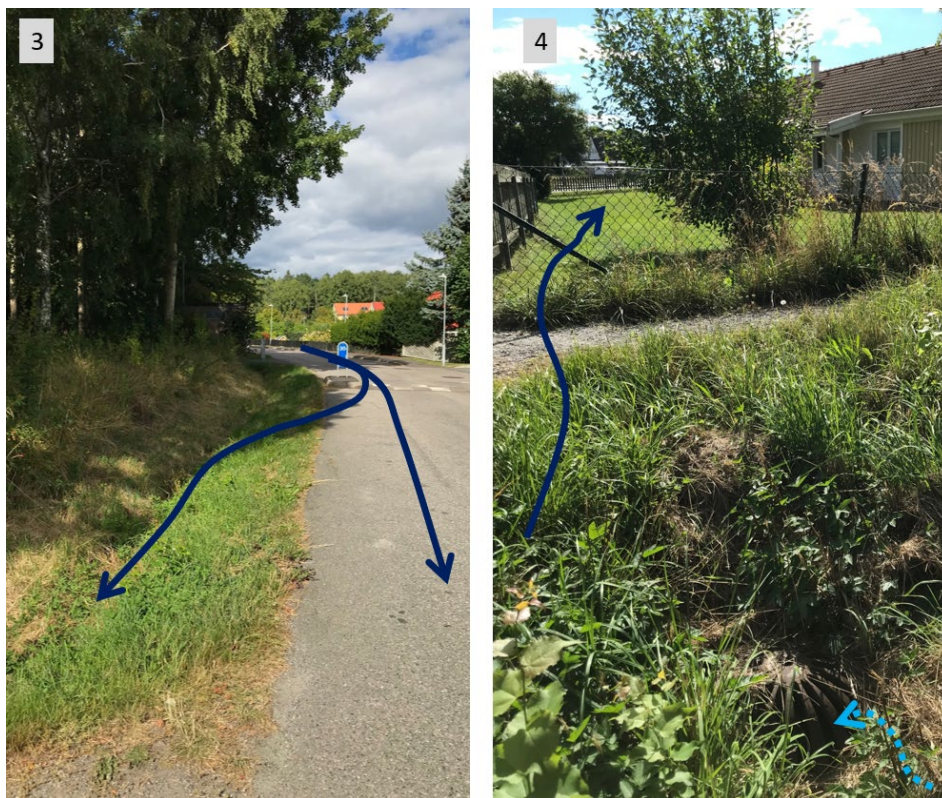
Figur 6 Bilden visar Aprikosgatan samt östra delen av fastigheten. Blå pilarna visar hur vatten rör sig genom området. Ljusblå pilen visar hur vatten rinner in till kupolbrunnen. (Foto: Sofia Polo).
